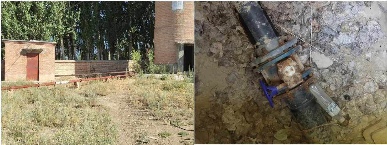
图 3.4-1 项目区水源，阀门井现状
