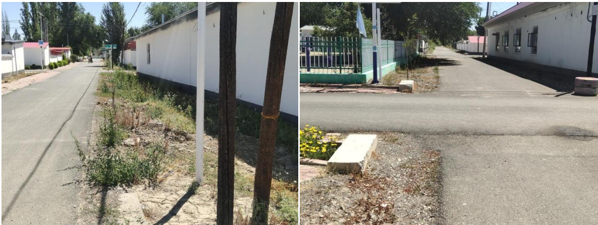
图 3.4-2 项目区现状道路
