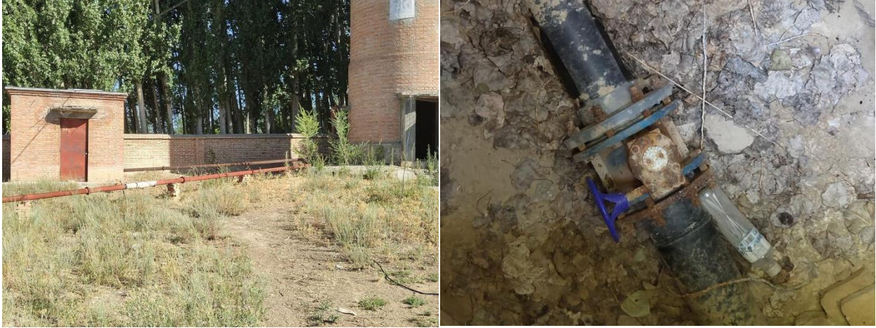
图 3.4-1 项目区水源，阀门井现状
